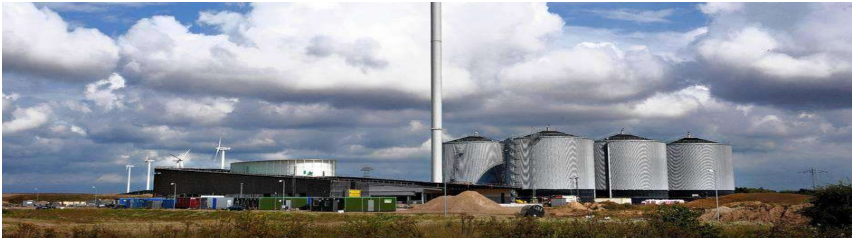
Maabjerg Energy Concept, biogas plant, Måbjerg, Denmark
