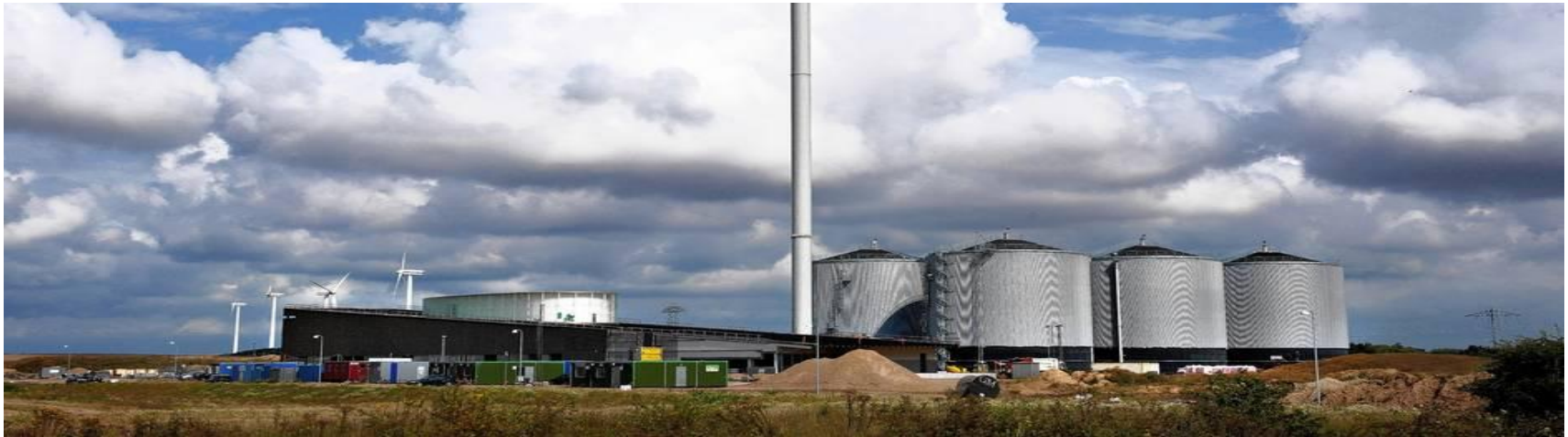
Maabjerg Energy Concept, biogas plant, Måbjerg, Denmark
